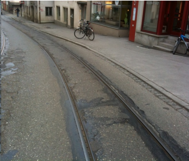
Bordsteine sind zum Teil bereits abgesenkt
